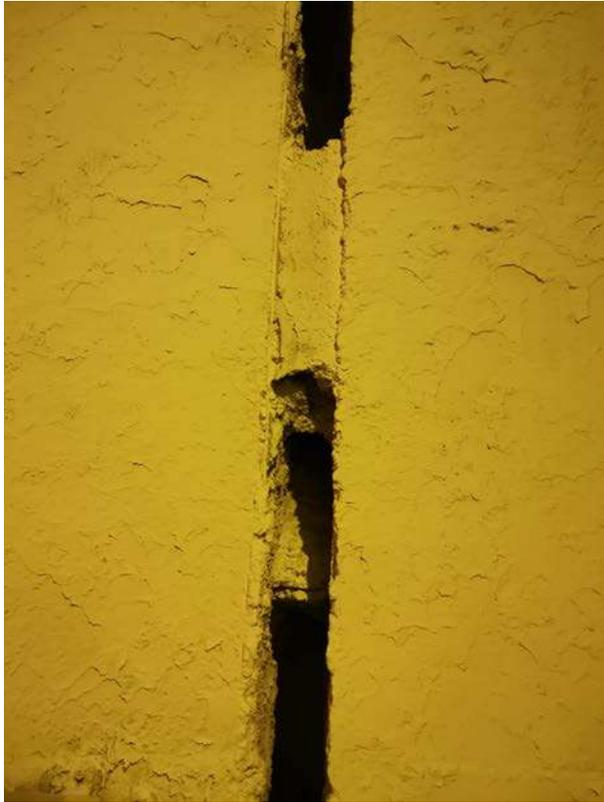
*Figura 4: Particolare stato di fatto giunto strutturale tipo tra le calotte della galleria*
