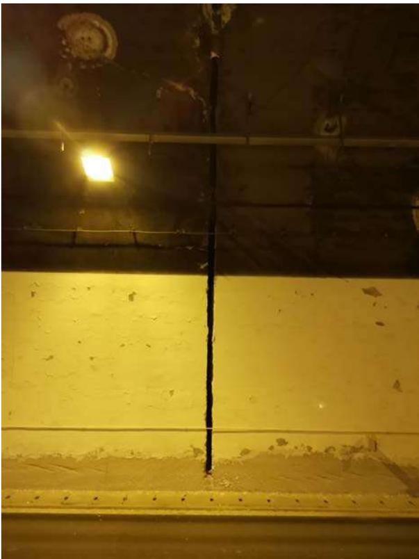
Figura 3: Giunto strutturale tipo tra le calotte della galleria
