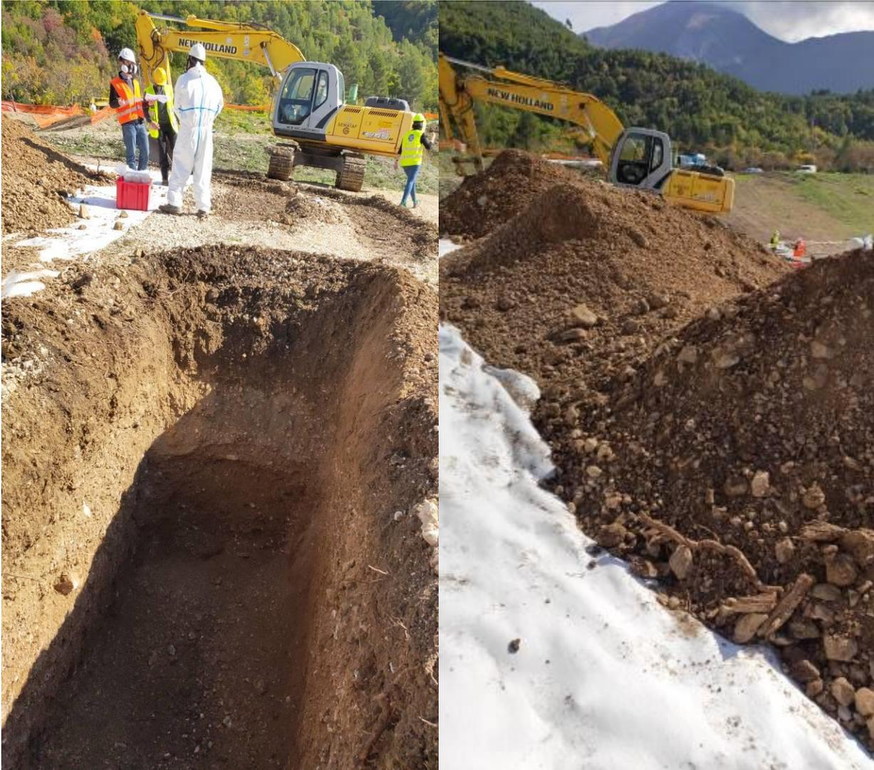
Panoramica - controlli eseguiti durante la realizzazione delle trincee tra agosto e ottobre 2020, particolare della trincea esterna alla Discarica 2A
